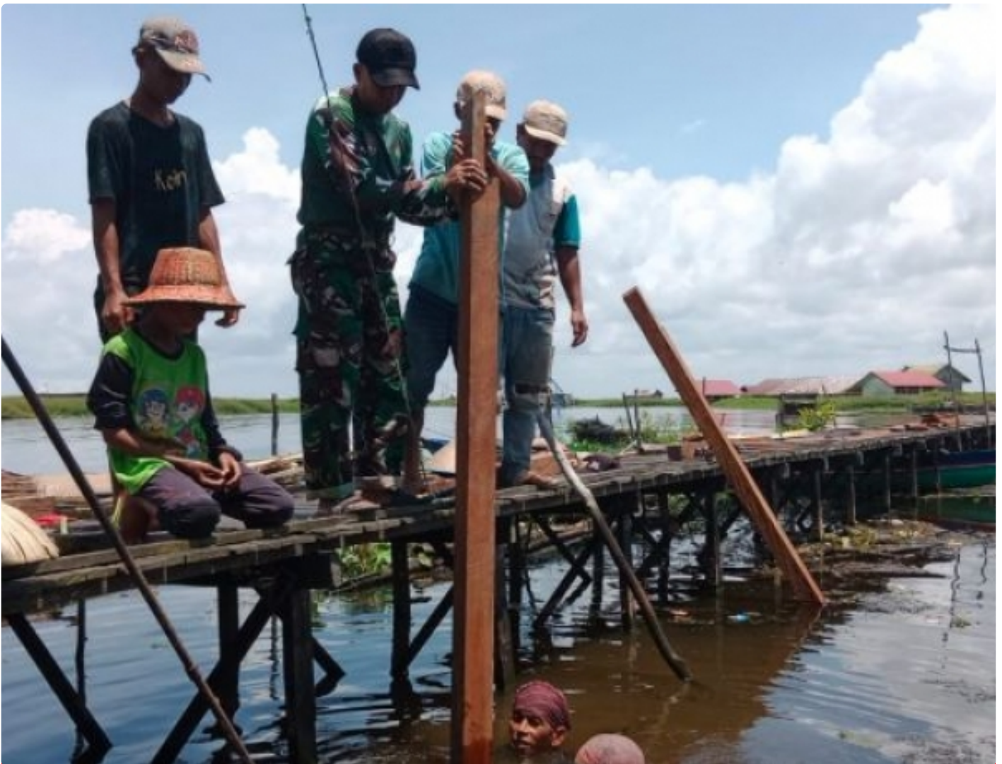
Pemasangan Tiang Penampungan Air
